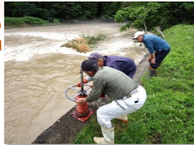
月橋堰：取水ゲート調整
