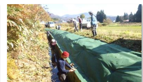
草刈り時危険防止のための防草シート設置 (R3)
