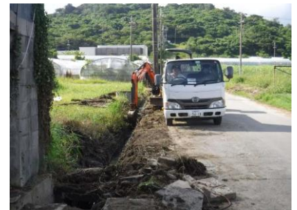
側溝の泥上げの様子
