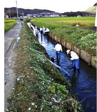
泥上げ作業の様子
