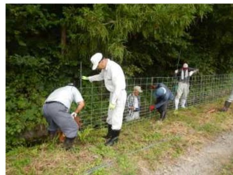
鳥獣害対策のフェンス設置
