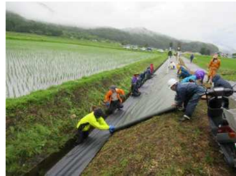
防草・抑草シートの敷設
