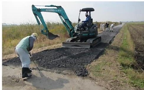
技術員による農道碎石施工
