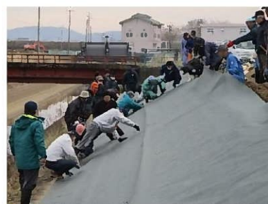
活動の様子(防草シートの敷設)
