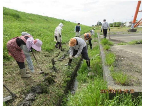
水路の泥上げ
