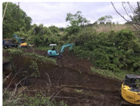
沈砂池土砂搬出
