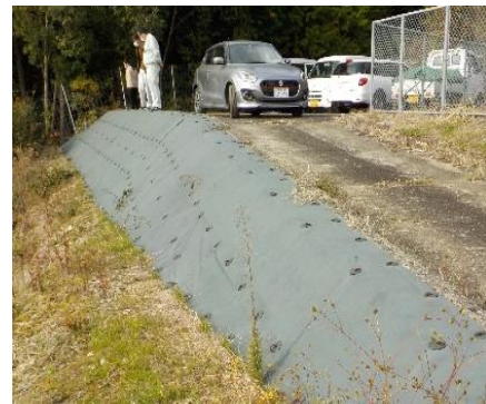
農道法面を防草シートで補強
