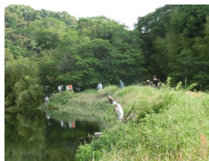
ため池堤体の草刈り
