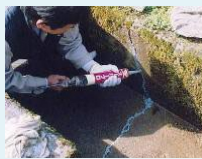
水路のひび割れ補修
