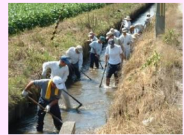
水路の泥上げ
