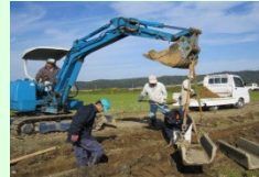
コンクリート水路の更新
