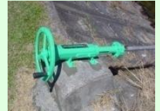
ゲート、バルブの更新
