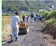
未舗装農道の舗装
