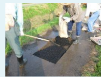
農道の部分補修
