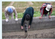
施設の機能診断
