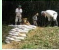
漏水箇所の補修
