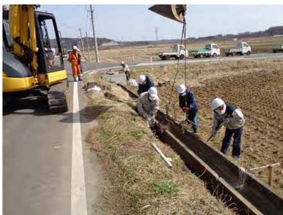
用水路補修工事の自主施工 (長寿命化活動)
