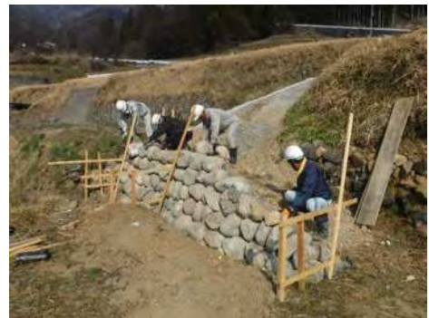
進入路石積補修
