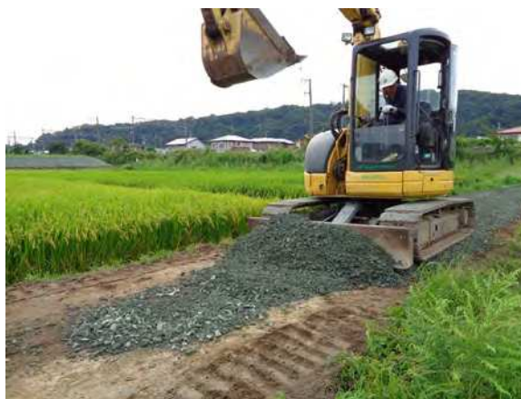
砕石等による農道補修
