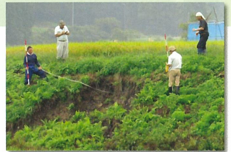
豪雨後の被災箇所調査
