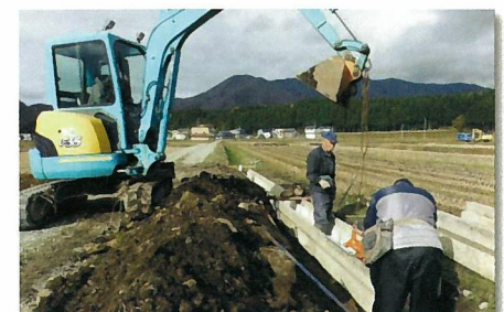
水路設置 直営工事
