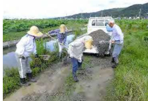
農道の路面の補修(バラス入れ)
