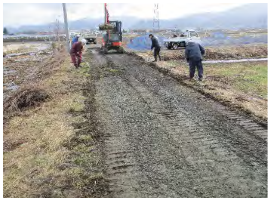
農道補修作業
