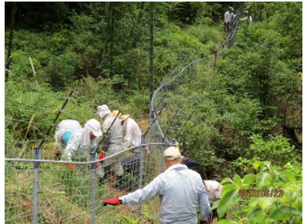
有害鳥獣対策（防護策等の補修）
