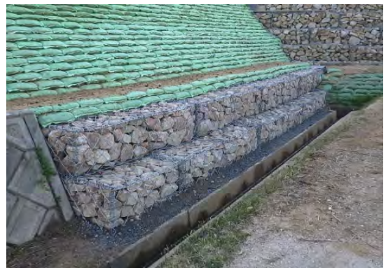
直営施工（ふとん籠 かご 工法）による補修工事
