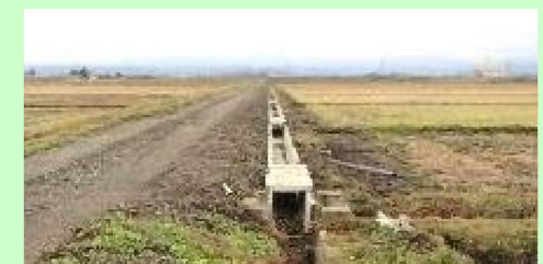
整備後の水路
