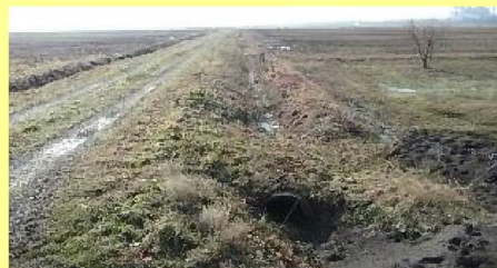
整備前の水路
